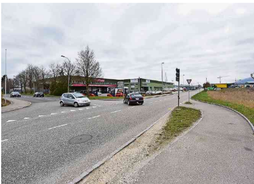
Auch die Kreuzung Industrie-/Unterführungsstrasse wird von der Sanierung betroffen sein.
